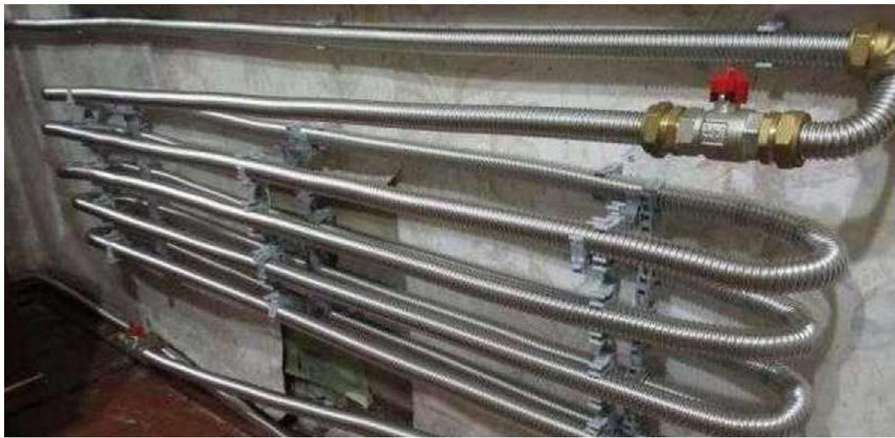
Slika 2.9. Valovita cijev od nehrđajućeg čelika u sustavu cjevovoda za potrebe grijanja, [15]
