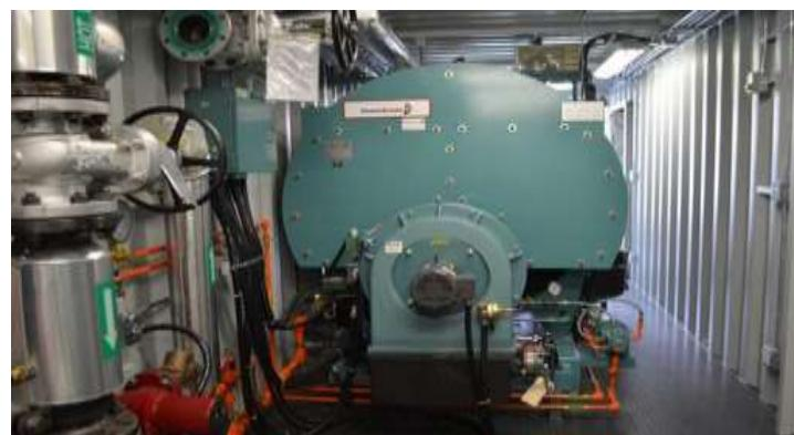
**Slika 5.4.** Plinska-blok kotlovnica u transportu, [25]
