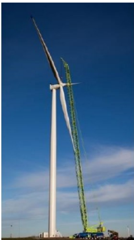
Slika 3. Vjetrogenerator s vodoravnom osi vrtnje [3]
