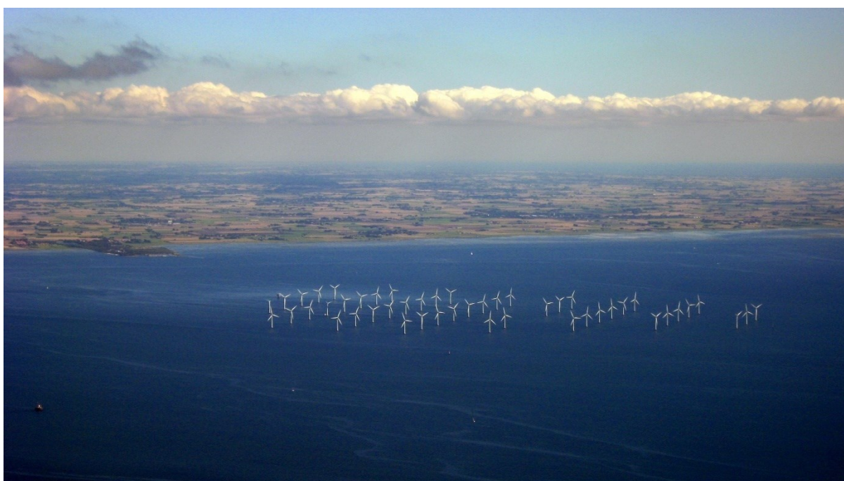
Slika 2. Priobalna vjetroelektrana Lillgrund, Švedska [2]
