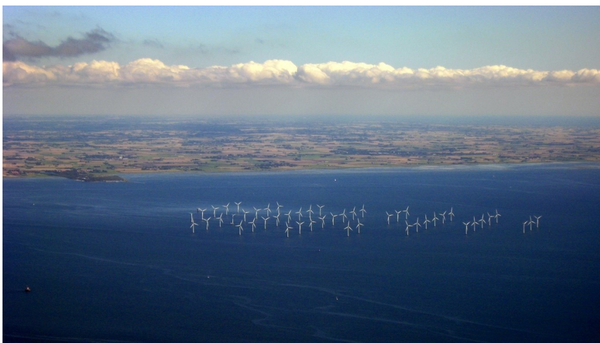
Slika 2. Priobalna vjetroelektrana Lillgrund, Švedska [2]
