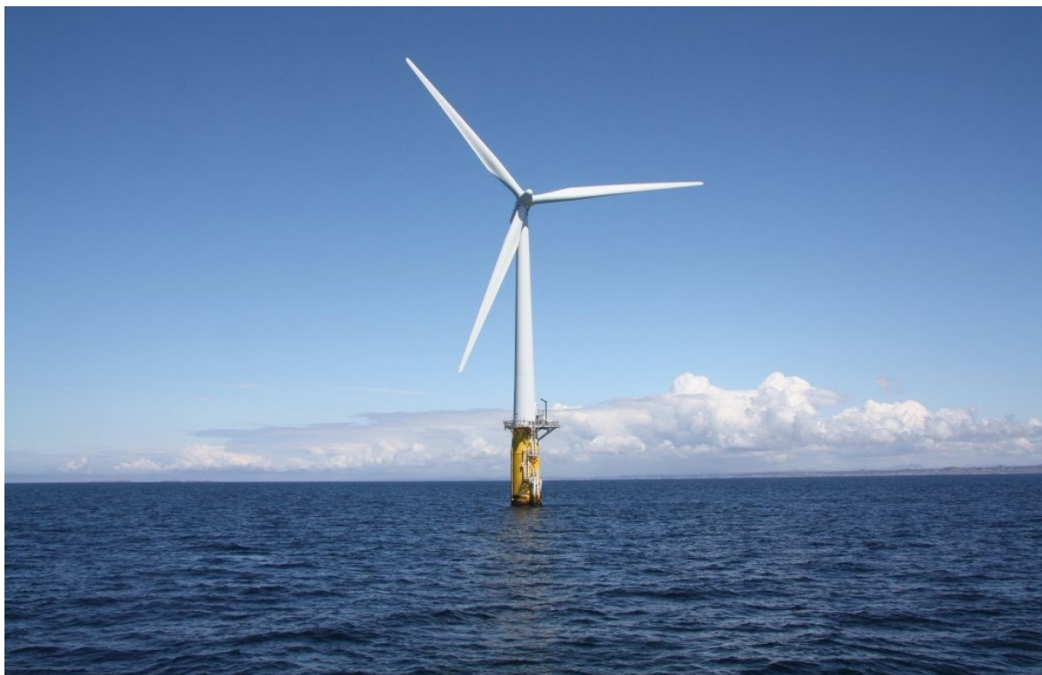
Slika 1. Hywind plutajući vjetrogenerator u Sjevernom Moru, Norveška [1]
