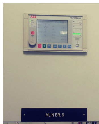
Slika 7.15. Polje Mlina br.6. sa zaštitnim relejom REF 542 plus
