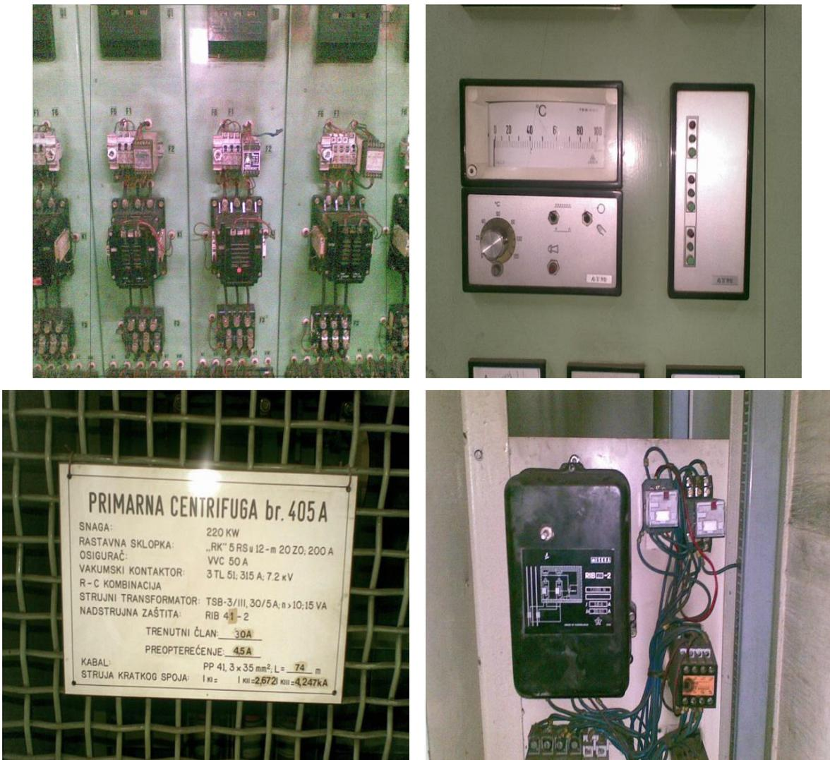
**Slika 4.1.** Prikaz 6 kV ćelije primarne centrifuge 220 kW i pripadajuće elektromehaničke zaštite kojom se štiti u Rudniku Banovići
