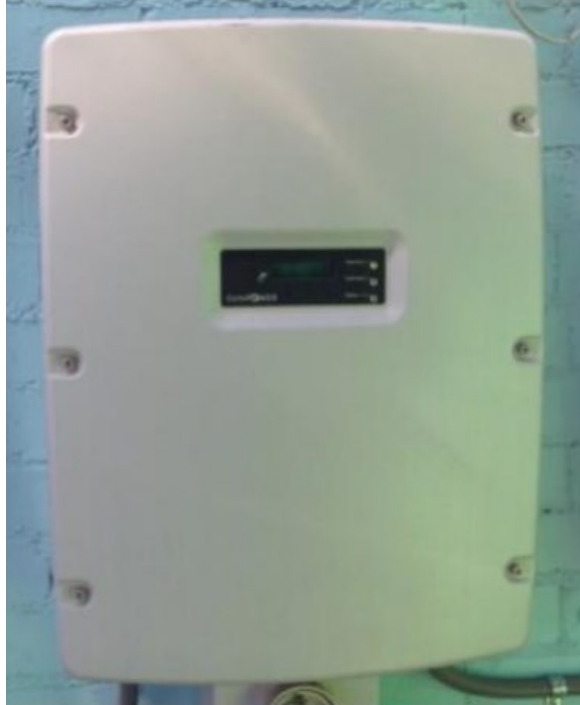
Slika 3.5. Izmjenjivač u fotonaponskom sustavu [11]
