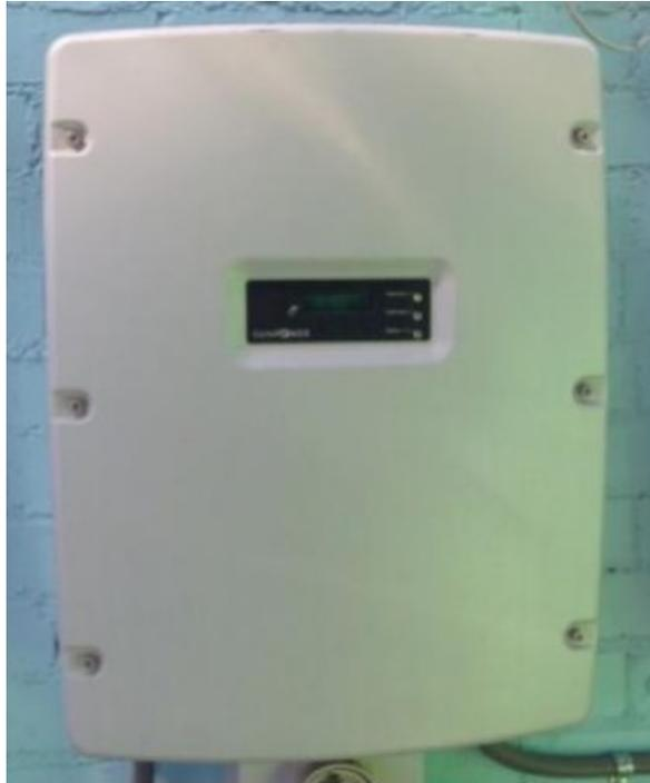
*Slika 3.5.* Izmjenjivač u fotonaponskom sustavu [11]
