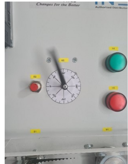
Sl. 4.15 Rad servomotora pri brzini vrtnje motora od 200 r/min
