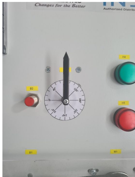
Sl 4.23 Pozicija servomotora nakon pokretanja za 90°
