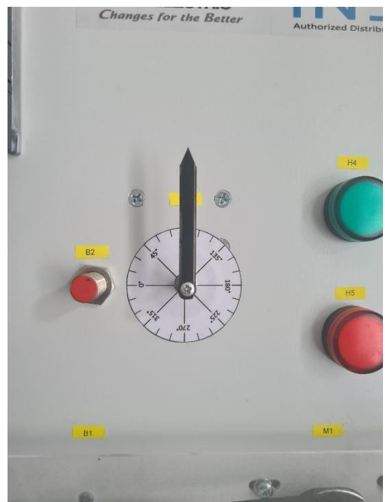
S1 4.23 Pozicija servomotora nakon pokretanja za  $90^\circ$
