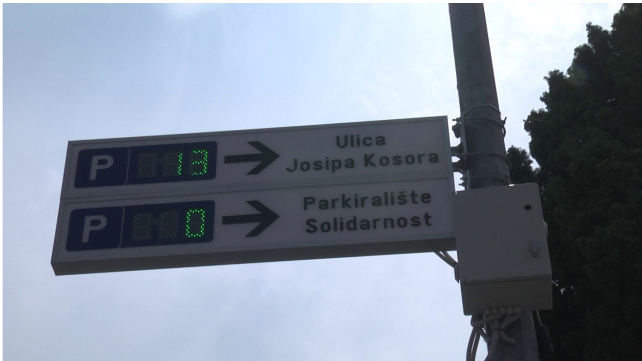
Slika 2.1 Uporaba ekrana za prikaz slobodnih mjesta na parkiralištu, [4]
