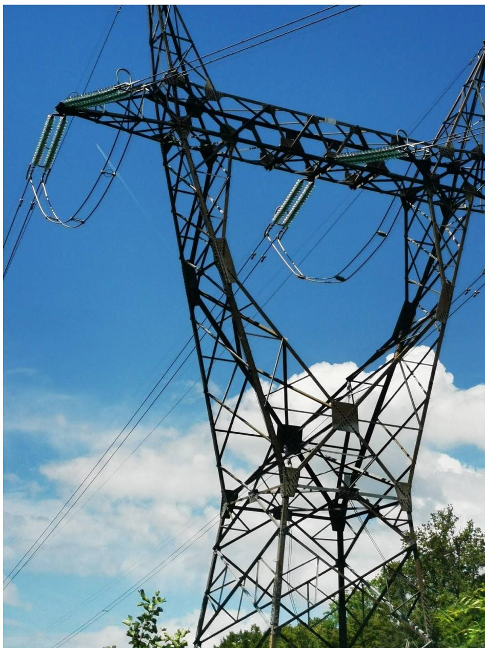
**Slika 5.2.** Jednostruki čeličnorešetkasti stup, tipa Y
