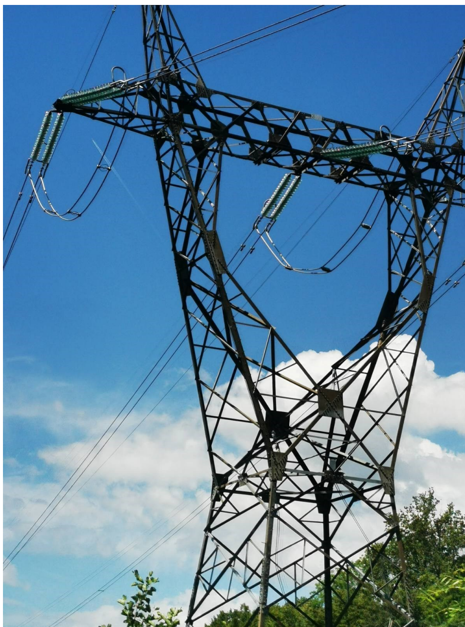
Slika 5.2. Jednostruki čeličnorešetkasti stup, tipa Y
