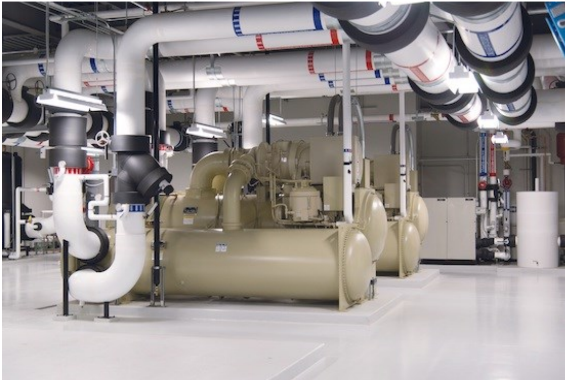
Slika 3.4.2. Prikaz vodom rashladnog uređaja u većim postrojenjima
