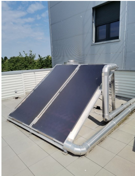
Slika 4.14. Solarni sustav za grijanje vode
