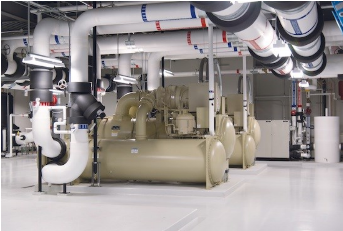
Slika 3.4.2. Prikaz vodom rashladnog uređaja u većim postrojenjima
