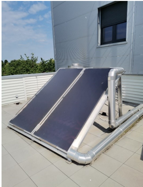
Slika 4.14. Solarni sustav za grijanje vode
