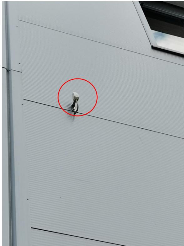
**Slika 4.9.** Senzor za rasvjetu
