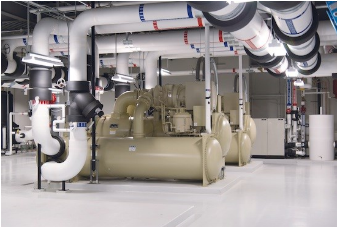
Slika 3.4.2. Prikaz vodom rashladnog uređaja u većim postrojenjima
