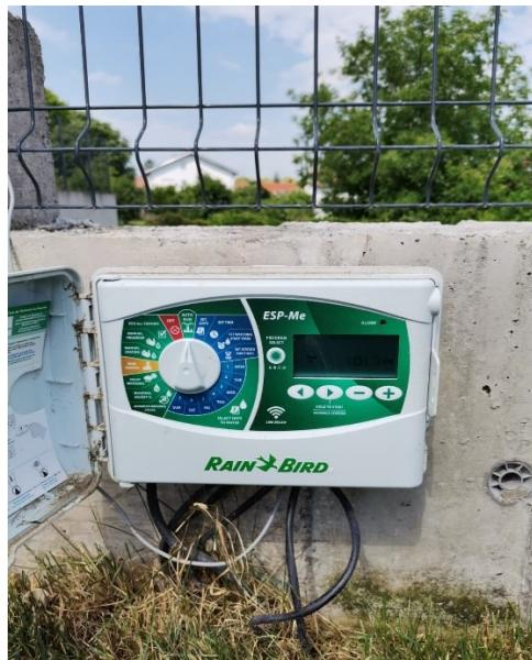
**Slika 4.8. Uređaj za postavke senzora vlage**
