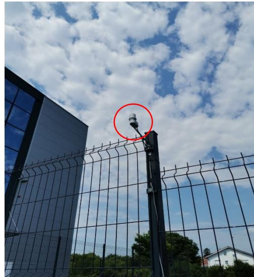
**Slika 4.7. Senzor vlage**
