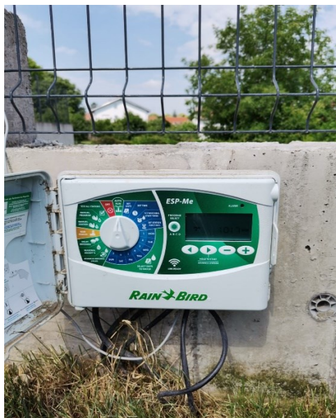
Slika 4.8. Uređaj za postavke senzora vlage
