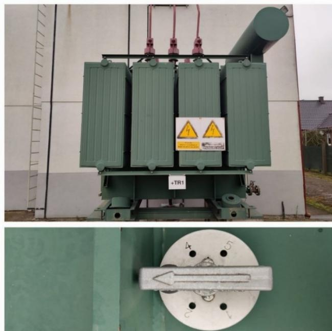
**Slika 3.4.** *Distributivni transformator s ručnom preklopkom (35/10 kV) nazivne snage 8000 kVA te njegova ručna preklopka.*
