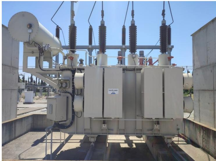
**Slika 3.7.** *Distributivni transformator s automatskom preklopkom (110/20/10 kV) nazivne snage 20000 kVA.*
