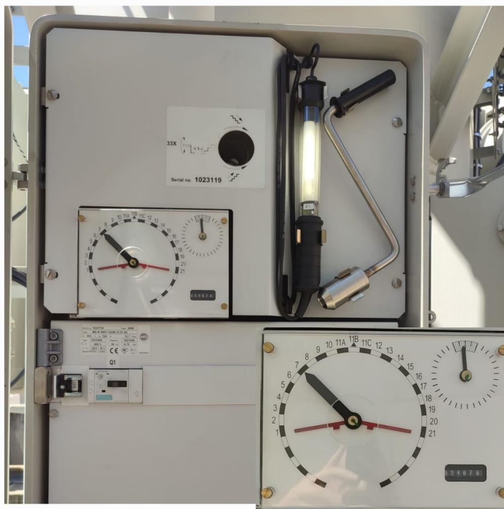
**Slika 3.8.** Prikaz položaja regulacije distributivnog transformatora s automatskom preklopkom (110/20/10 kV) nazivne snage 20000 kVA.
