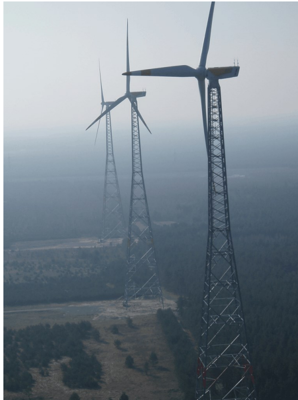
Slika 4.1.2.1. Primjer rešetkaste izvedbe stupa vjetroagregata [16]
