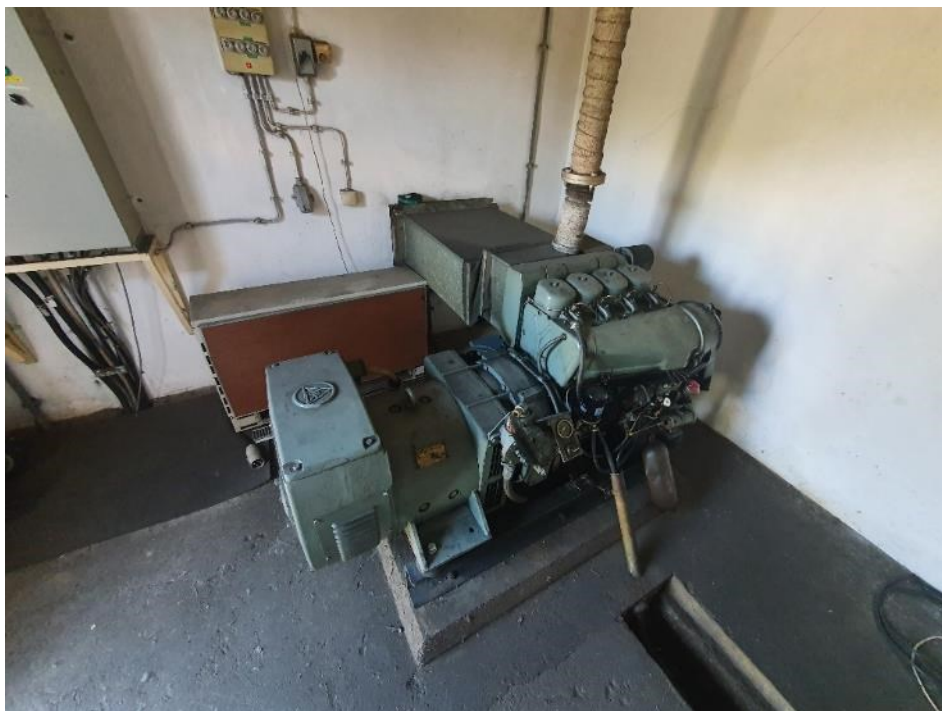
Slika 5.12. Diesel-agregat (fotografirano 7. srpnja 2022.)
