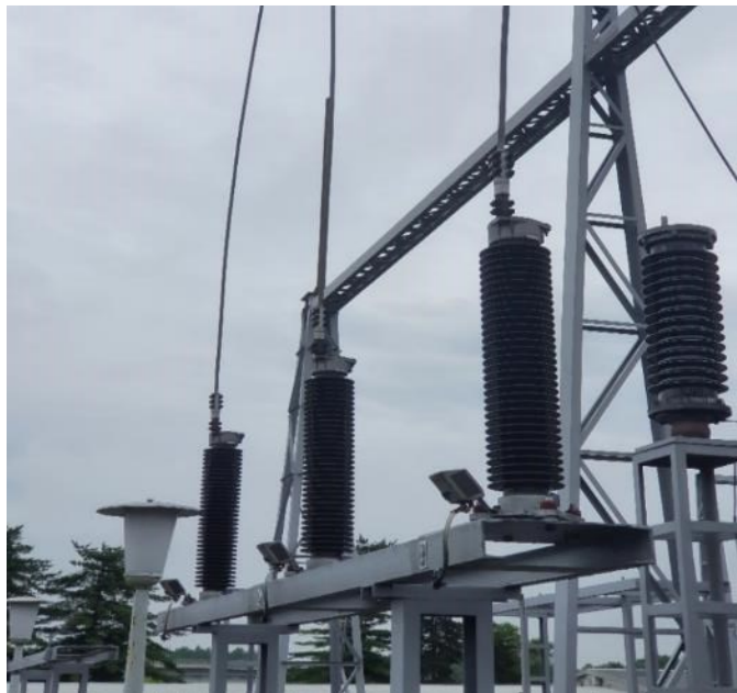
Slika 5.3. Odvodnici prenapona (fotografirano 9. kolovoza 2022.)
