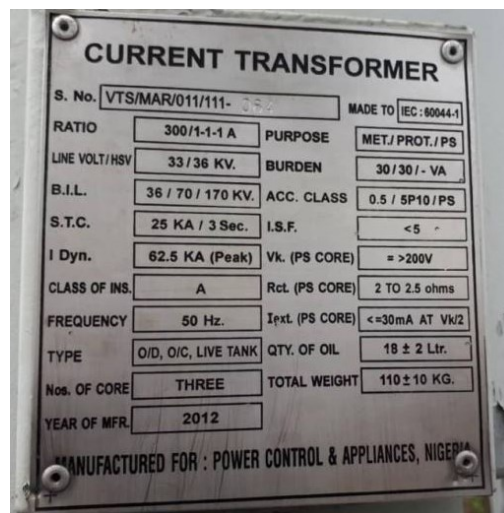
Sl. 4.10 . Natpisna pločica strujnog mjernog transformatora. [19]
