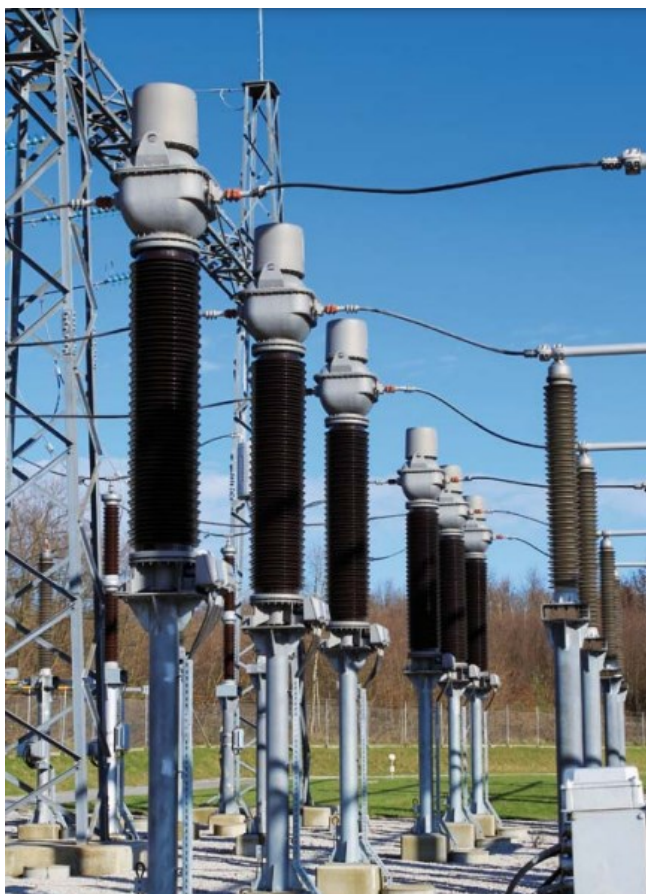
Slika 3.4. Kombinirani mjerni transformatori [10]
