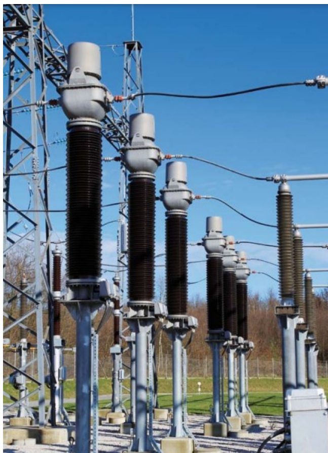
Slika 3.4. Kombinirani mjerni transformatori [10]
