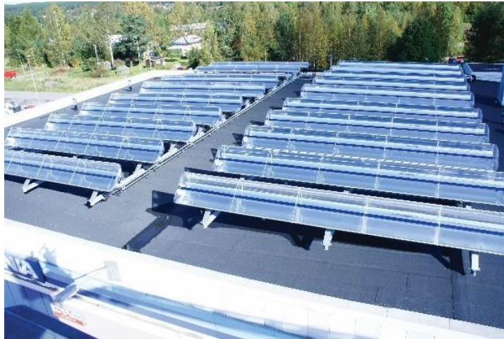
Slika 3.6.7. Polje od 20 paraboličnih kolektora [23].
