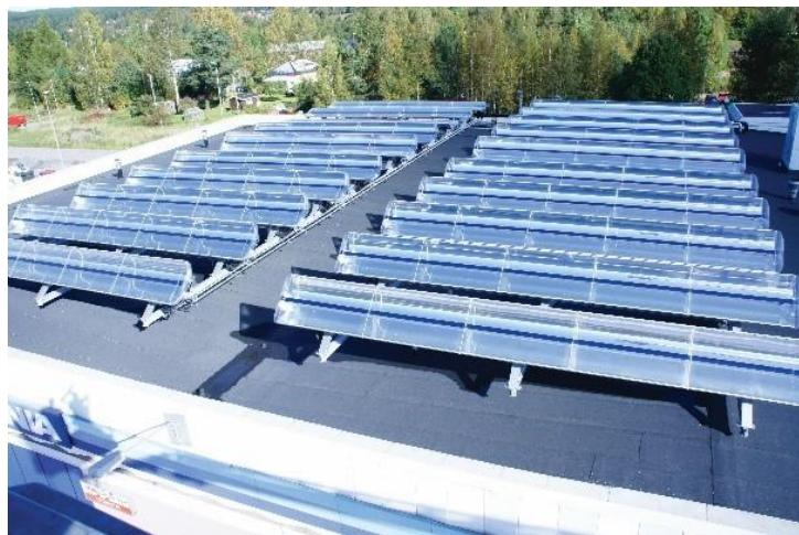
Slika 3.6.7. Polje od 20 paraboličnih kolektora [23].
