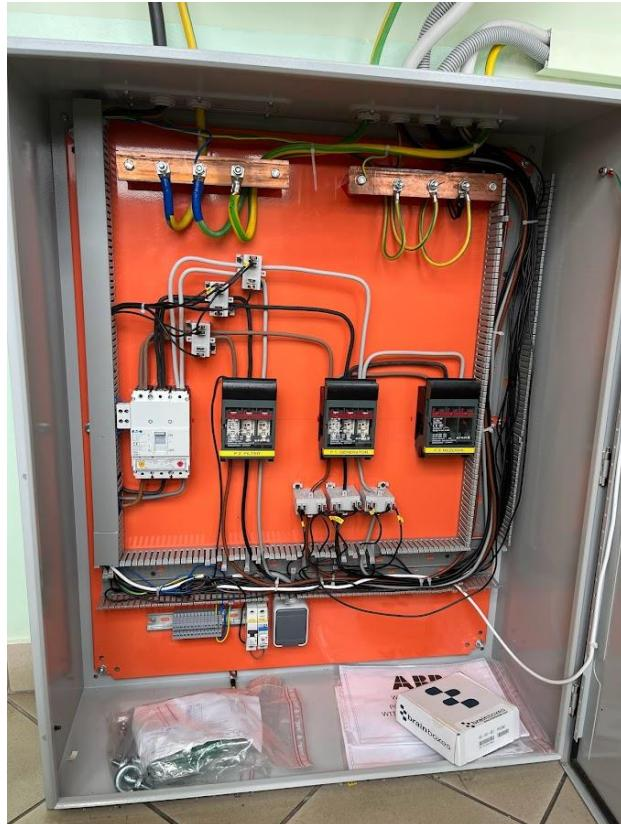
*Slika 4.3. Strujni mjerni transformatori*
