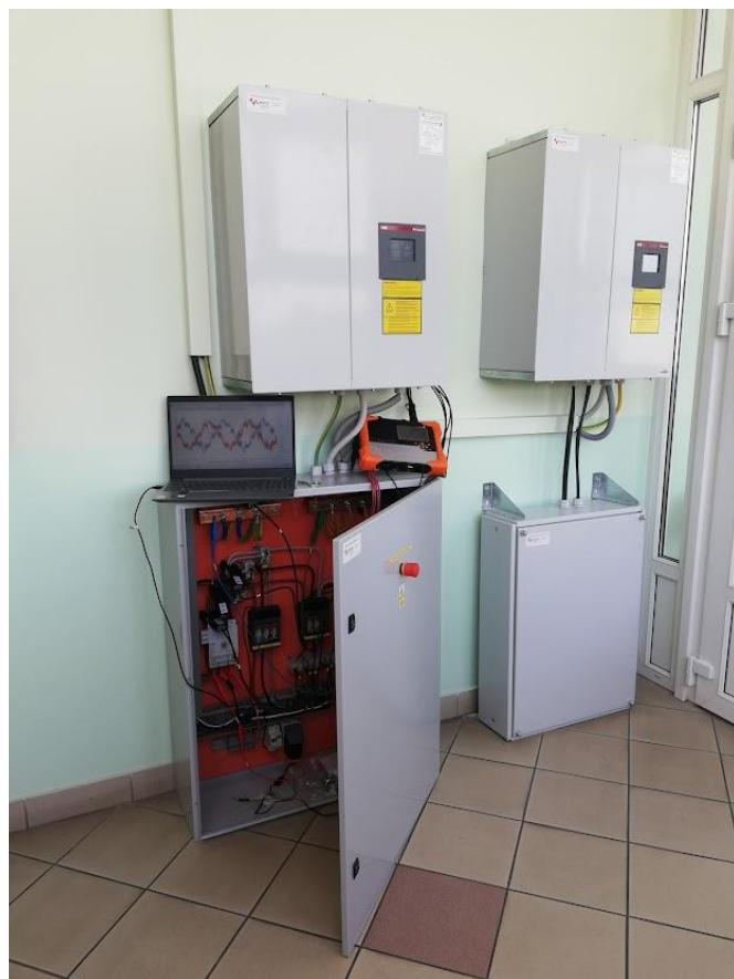
Slika 4.1. Aktivni filter (lijevo) i generator harmonika (desno)
