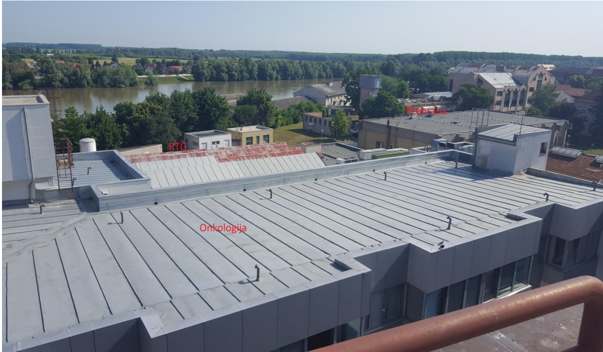
Slika 5.2. Zgrade na čije krovove se postavljaju fotonaponski moduli
