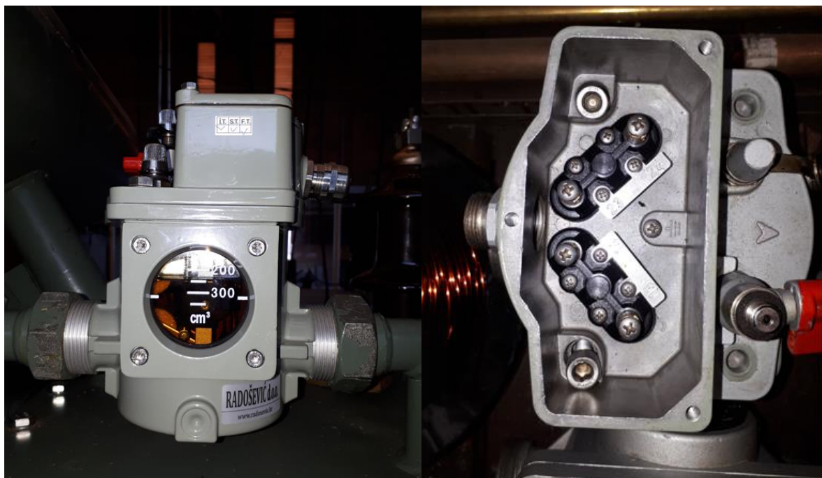
Sl. 3.15. Prikaz Buchholz releja i njegovih priključaka za ispitivanje
