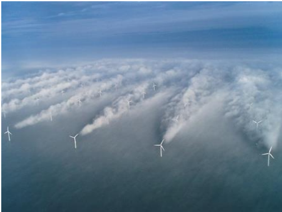
Sl. 4.12. Efekt međusobnog zaklanjanja (zavjetrine) [21]
