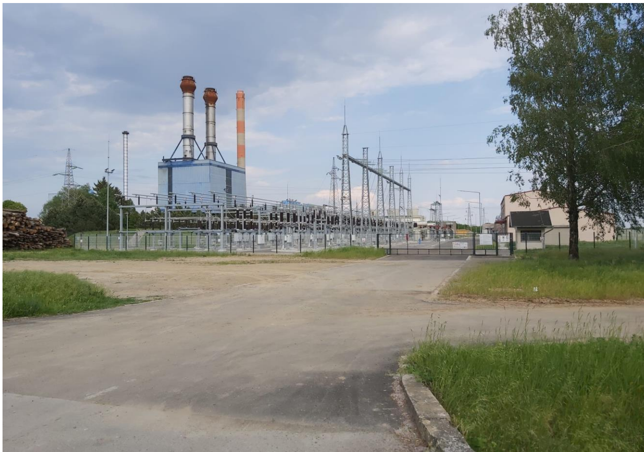
Slika 4.1. TS Osijek 2 110/35/10 kV.
