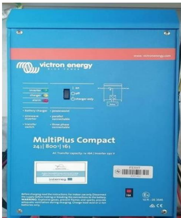
Slika 4.5. MultiPlus Compact 24/800/16 – izmjenjivač/punjač
