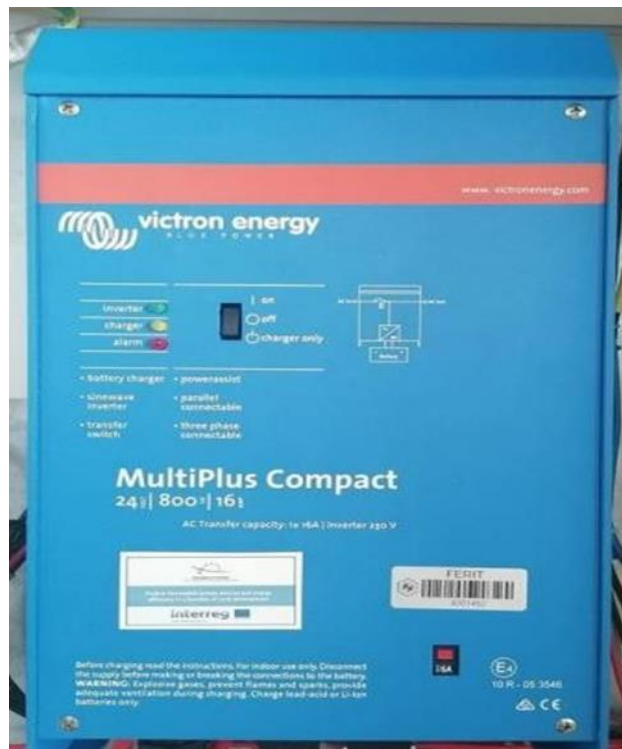
Slika 4.5. MultiPlus Compact 24/800/16 – izmjenjivač/punjač
