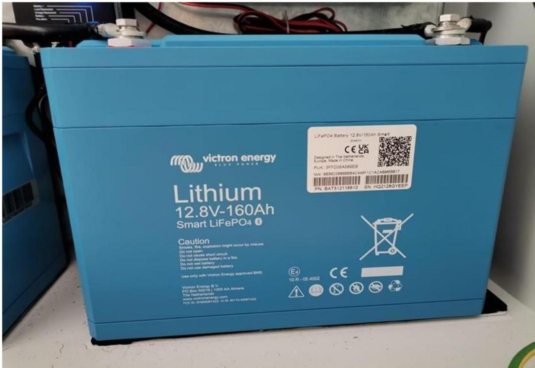
*Slika 4.12. Victron Energy LiFePO baterija – 12.8 V, 160 Ah*
