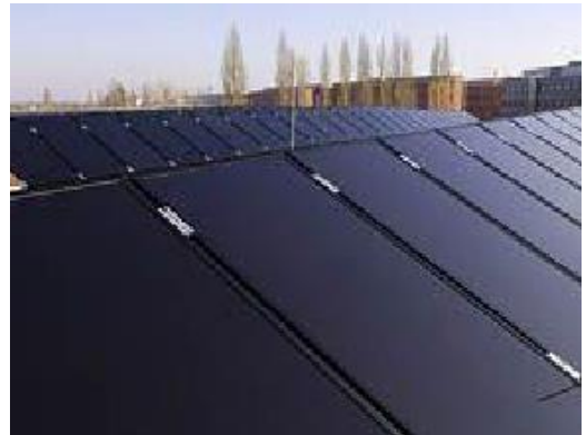
Slika 3.8, Prikazuje tankoslojni kandijev telurid fotonaponski modul [20]
