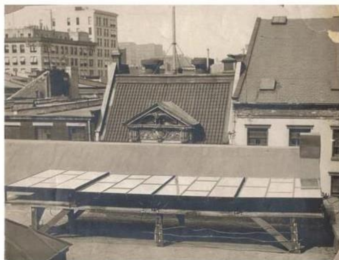
Slika 2.4, Prvi solarni niz, 1884. godina [3]
