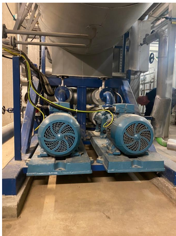
Slika 4.10. Pumpe kondenzatora (fotografirano 10.siječnja 2023.)
