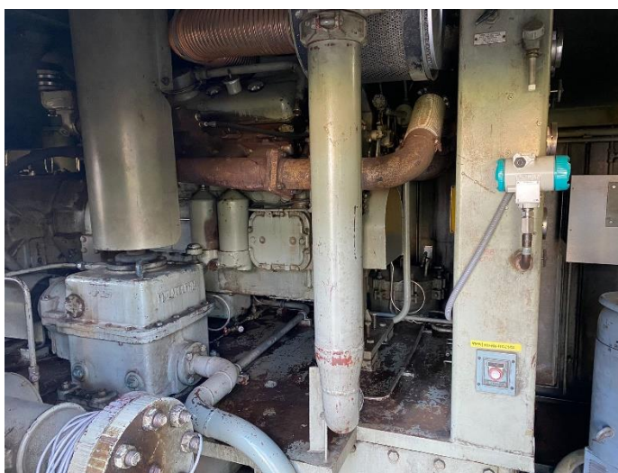
Slika 3.6. Prikaz startnog diesel motora (fotografirano 8.lipnja 2022.)
