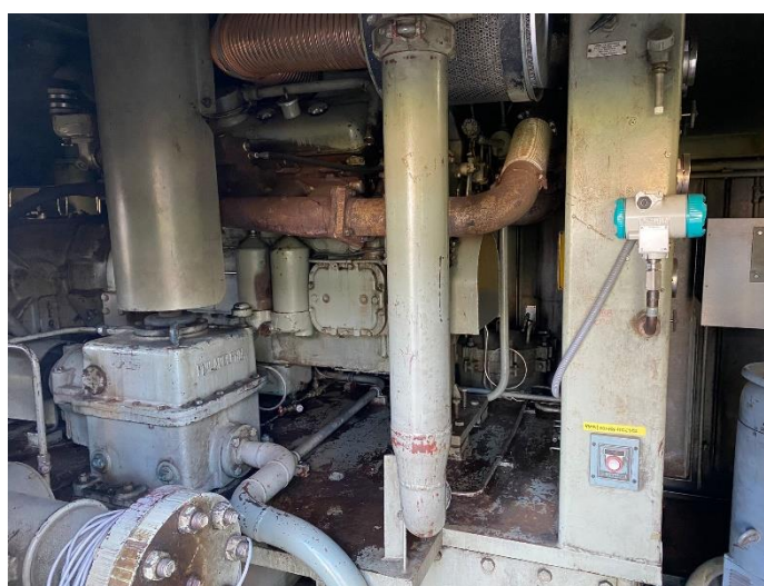
Slika 3.6. Prikaz startnog diesel motora (fotografirano 8.lipnja 2022.)
