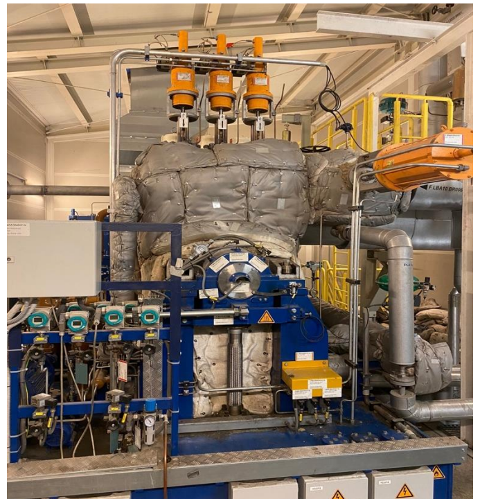
Slika 4.7. Parna turbina (fotografirano 10. siječnja 2023.)
