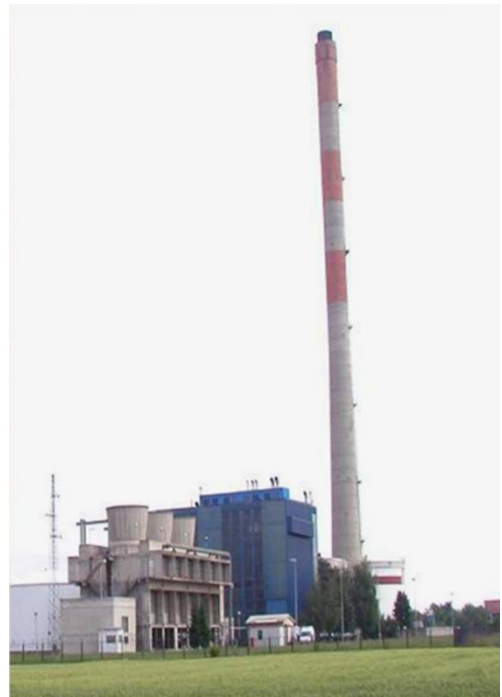
Slika 2.3. Glavni blok snage 45MW [1]
