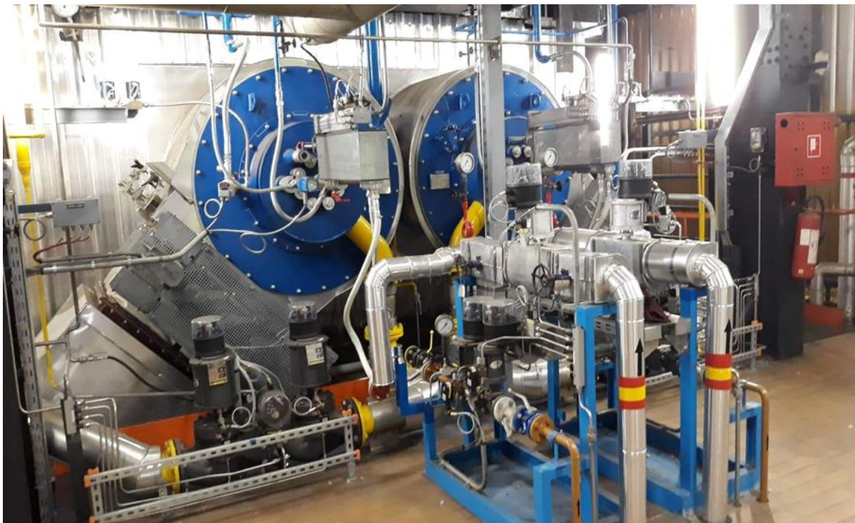
Slika 3.14.. Prikaz dva plemenika na nivou 2 (fotografirano 8.lipnja 2022.)
