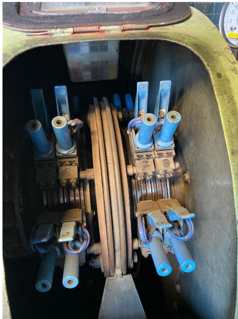
Slika 3.9. Prikaz četkica za uzбудu (fotografirano 8.lipnja 2022.)
