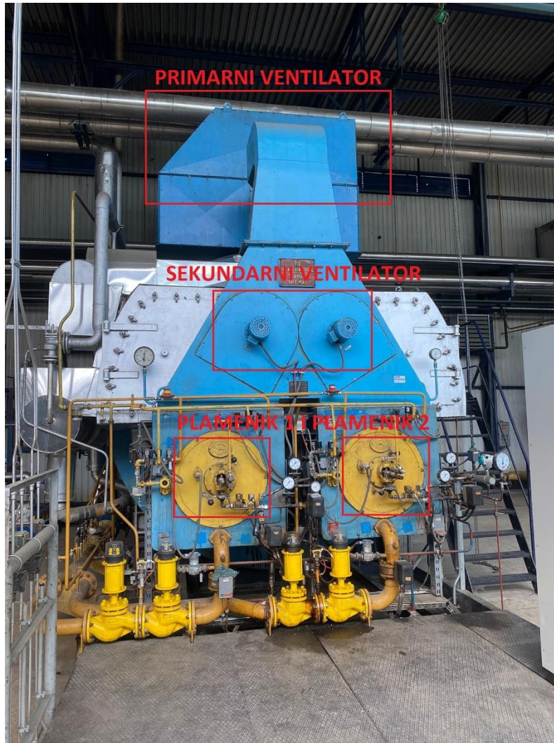
Slika 3.3. Prikaz prednjeg dijela kotla 1 (fotografirano 8.lipnja 2022.)
