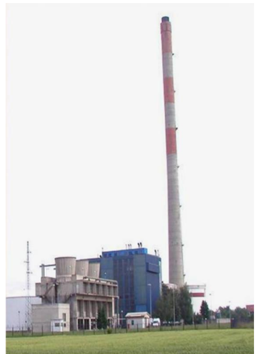
Slika 2.3. Glavni blok snage 45MW [1]
