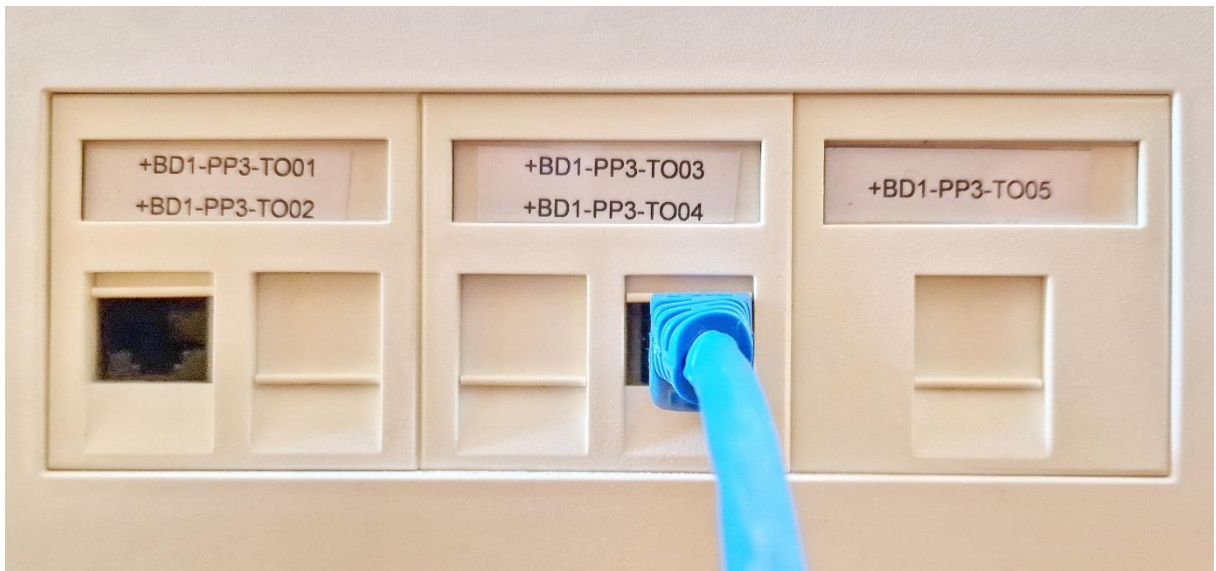
Slika 3.2 Primjer označavanja RJ45 priključnica u prostorijama
