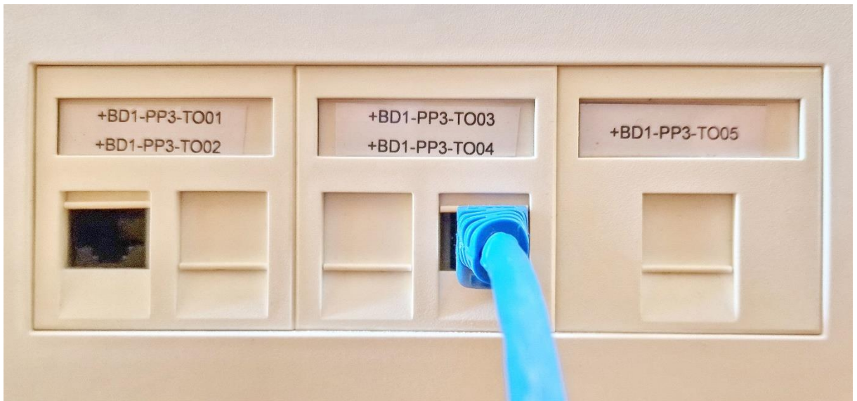
Slika 3.2 Primjer označavanja RJ45 priključnica u prostorijama
