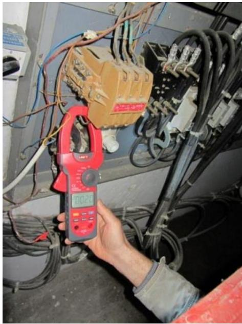
Sl. 3.2. Mjerenje struje izvoda javne rasvjete sa strujnim klijestima [26]
