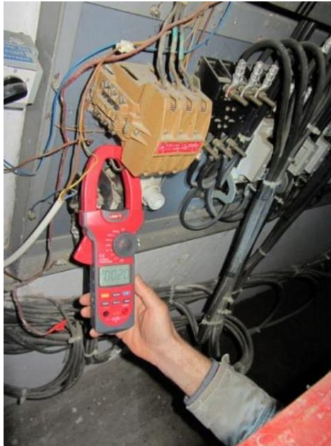
Sl. 3.2. Mjerenje struje izvoda javne rasvjete sa strujnim kliještima [26]
