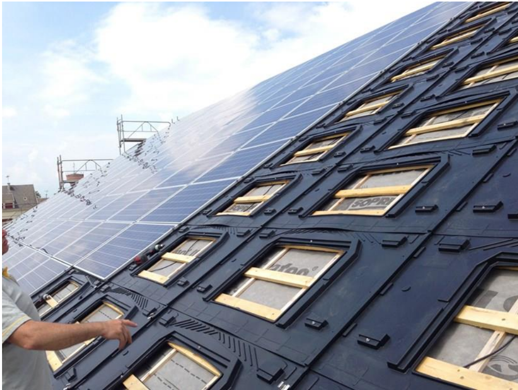
Sl.3.3. Montaža integrirane sunčane elektrane na krovu [14]
