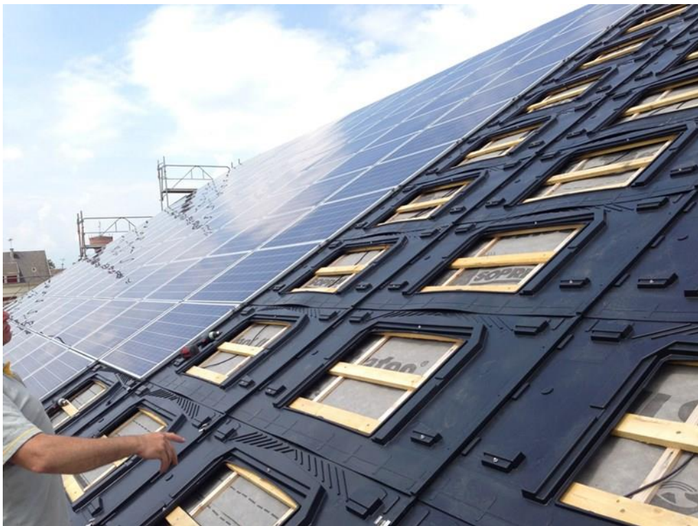
Sl.3.3. Montaža integrirane sunčane elektrane na krovu [14]
