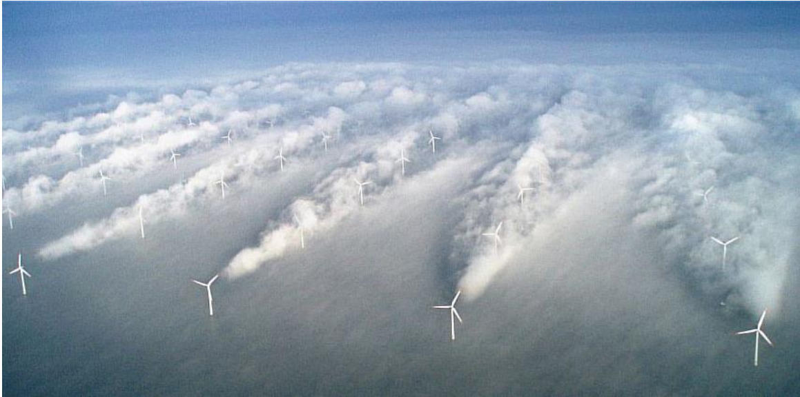
Slika 2.6 Efekt međusobnog zaklanjanja vjetroturbina u vjetroelektrani [6]
