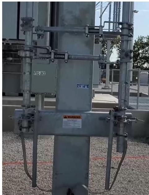
Sl. 4.1. Mehanički blokirane ručke uzemljenja [8]
