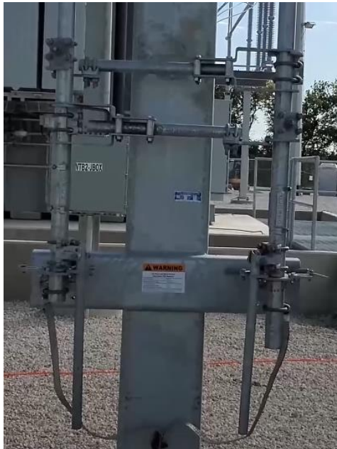
Sl. 4.1. Mehanički blokirane ručke uzemljenja [8]
