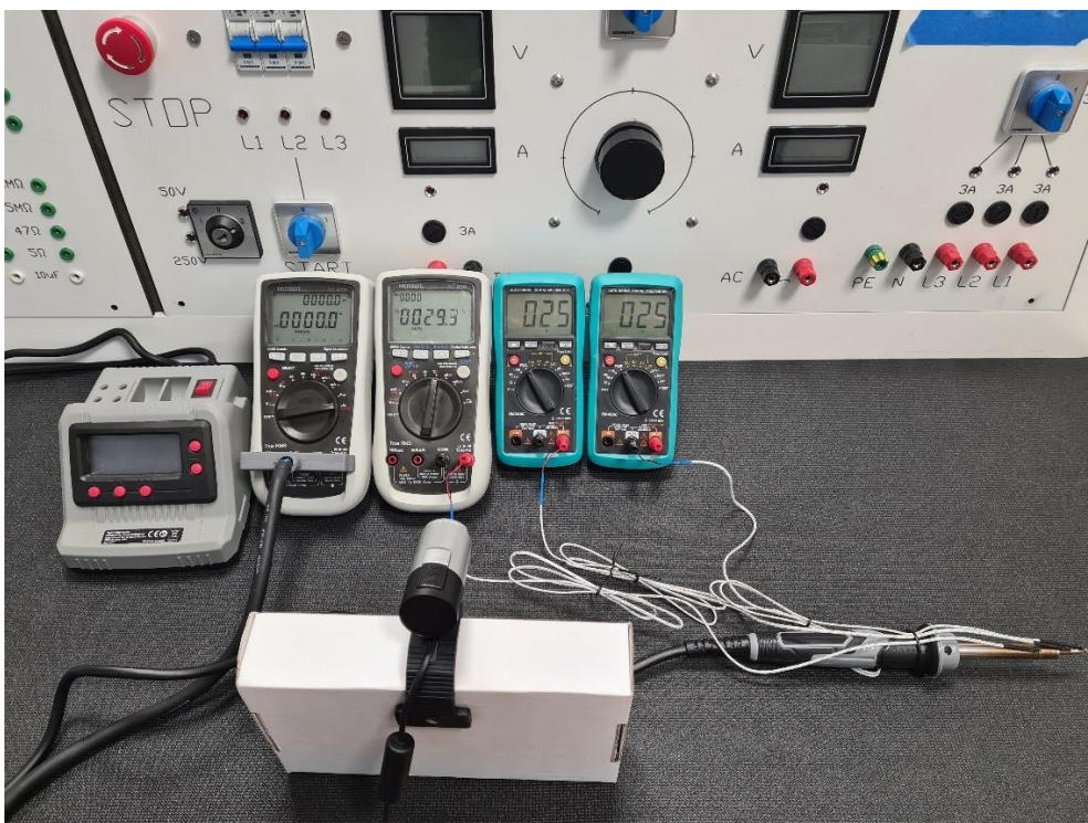
Slika 6.6. prikaz kompletnog spoja potrebnog za obavljanje mjerenja na lemnjici Conrad Electronic LSL-450
