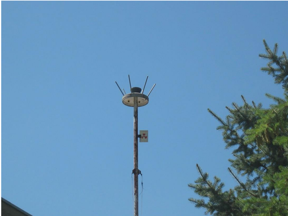
Slika 4.5. Radioaktivni gromobran
