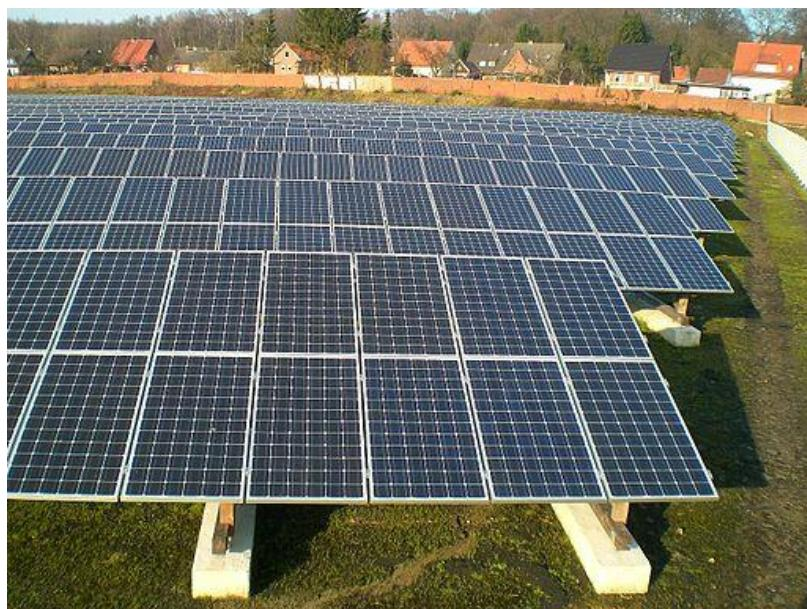
**Slika 3.1.** Prikaz fotonaponske elektrane s fiksnim položajem [10]
