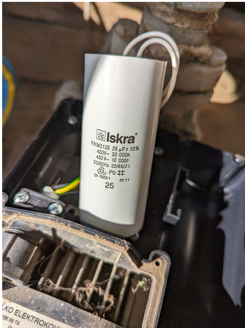
Slika 5.4. Radni kondenzator pogonskog motora
