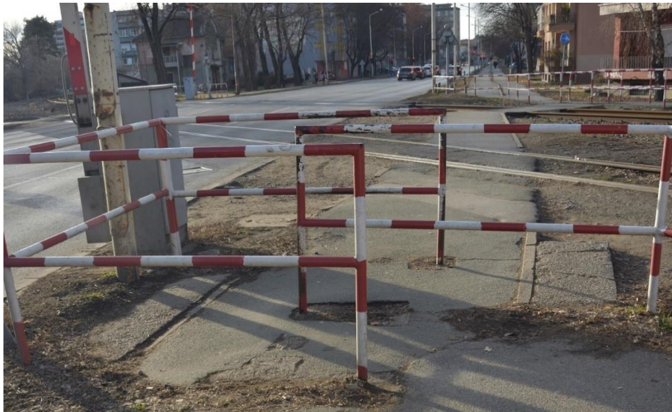
Slika 5.4. Pružni prijelaz u Vukovarskoj Ulici
