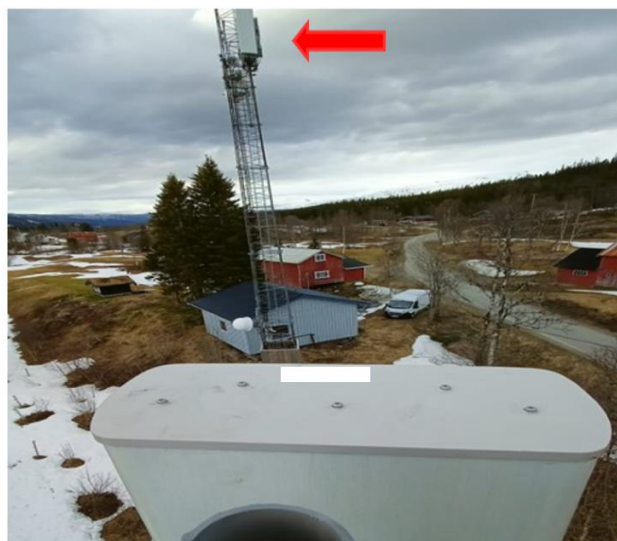
Slika 4.9 Antena drugog operatera koji uzrokuje nastanak PIM-a na baznoj stanici
