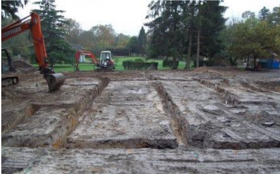
Slika 3.2. Metoda postavljanja mrežastih uzemljivača u jarak.
