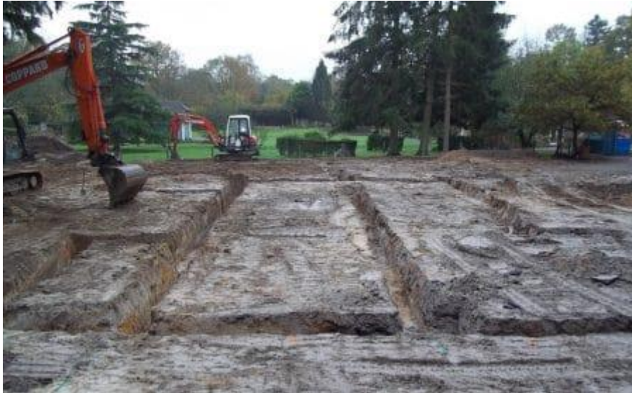
Slika 3.2. Metoda postavljanja mrežastih uzemljivača u jarak.
