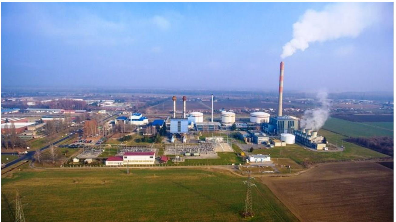
Slika 4.1. – Termoelektrana – toplana Osijek
